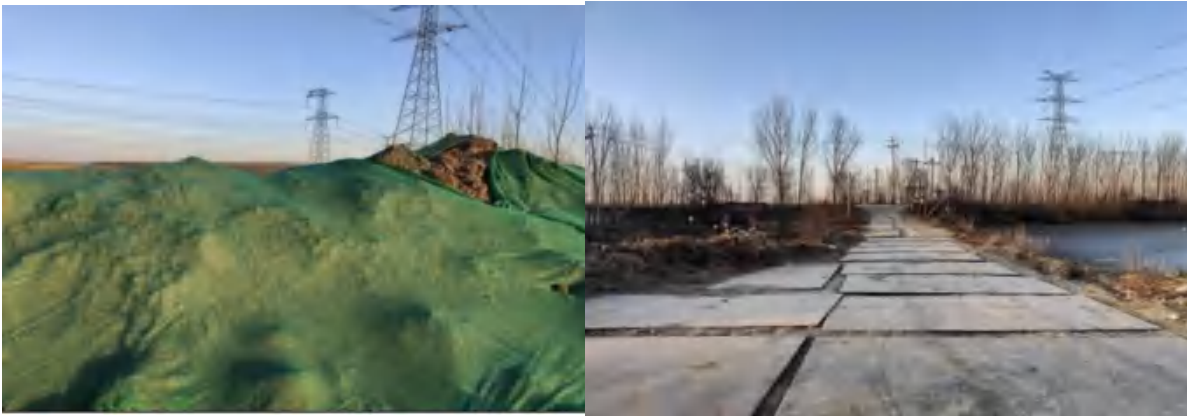
塔基施工区临时堆土苫盖
