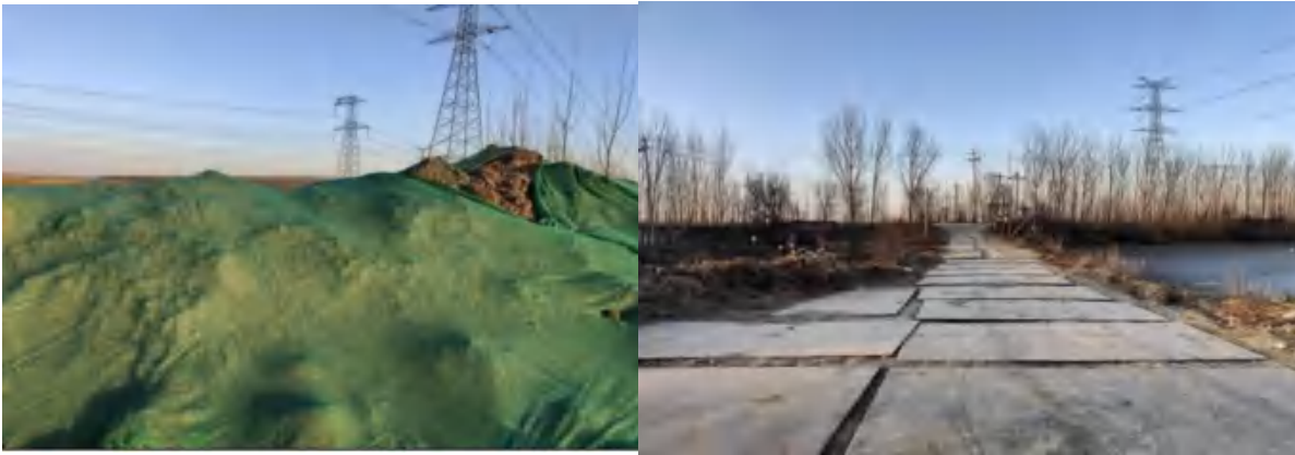
塔基施工区临时堆土苫盖
